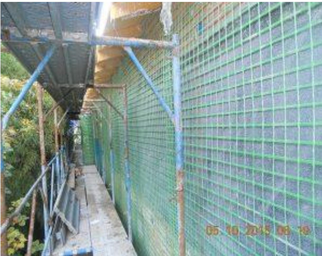
Figura 1a. Applicazione della rete in fibra di vetro per armare il successivo intonaco
