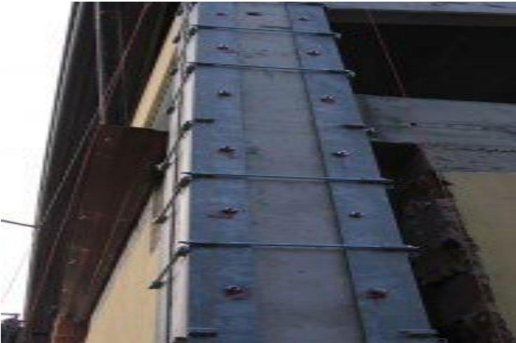
Figura 4b. Rinforzo di pilastro mediante calastrellatura con angolari d'acciaio
