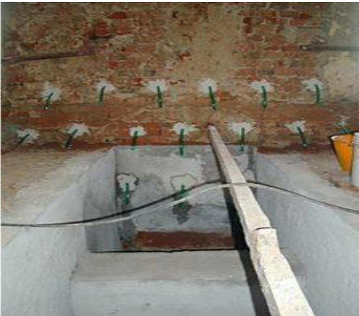
Figura 3 a. Intervento puntuale di rinforzo dell'ancoraggio di una catena mediante iniezioni
