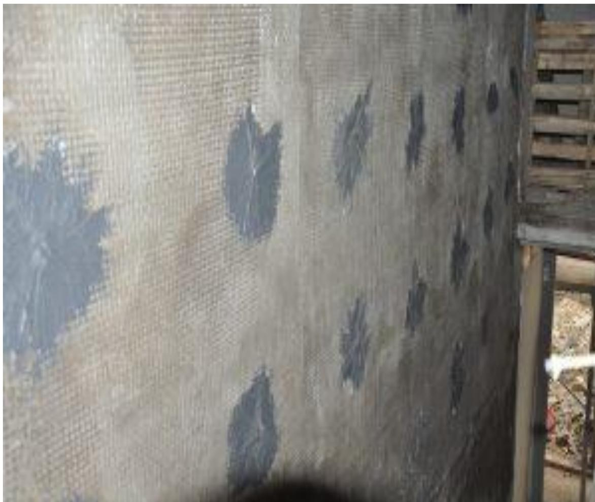
Figura 2. Rinforzo dell'intonaco mediante incollaggio con resina epossidica di una rete in materiale composito e connessa trasversalmente con corde fioccate e impregnate con la medesima resina di incollaggio.
