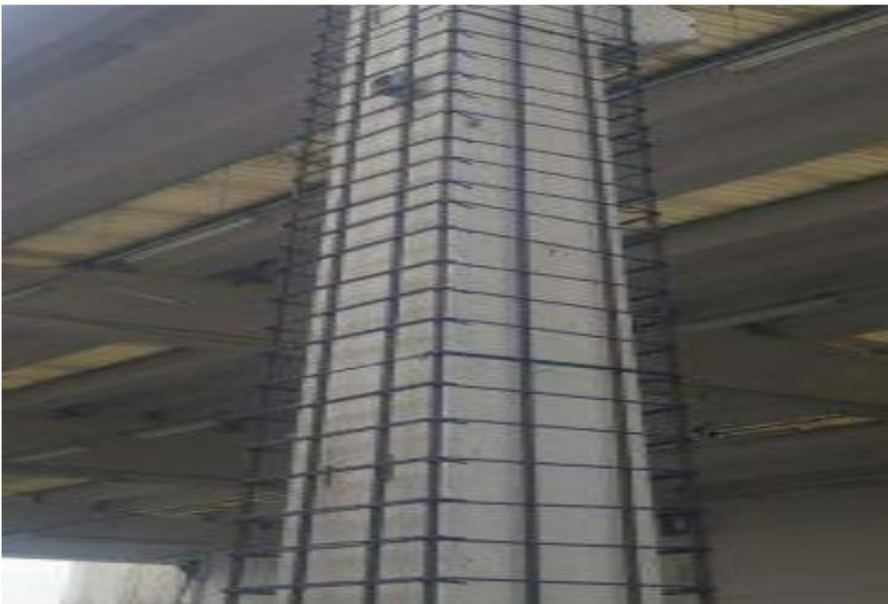
Figura 4a. Rinforzo di pilastro mediante incamiciatura armata
