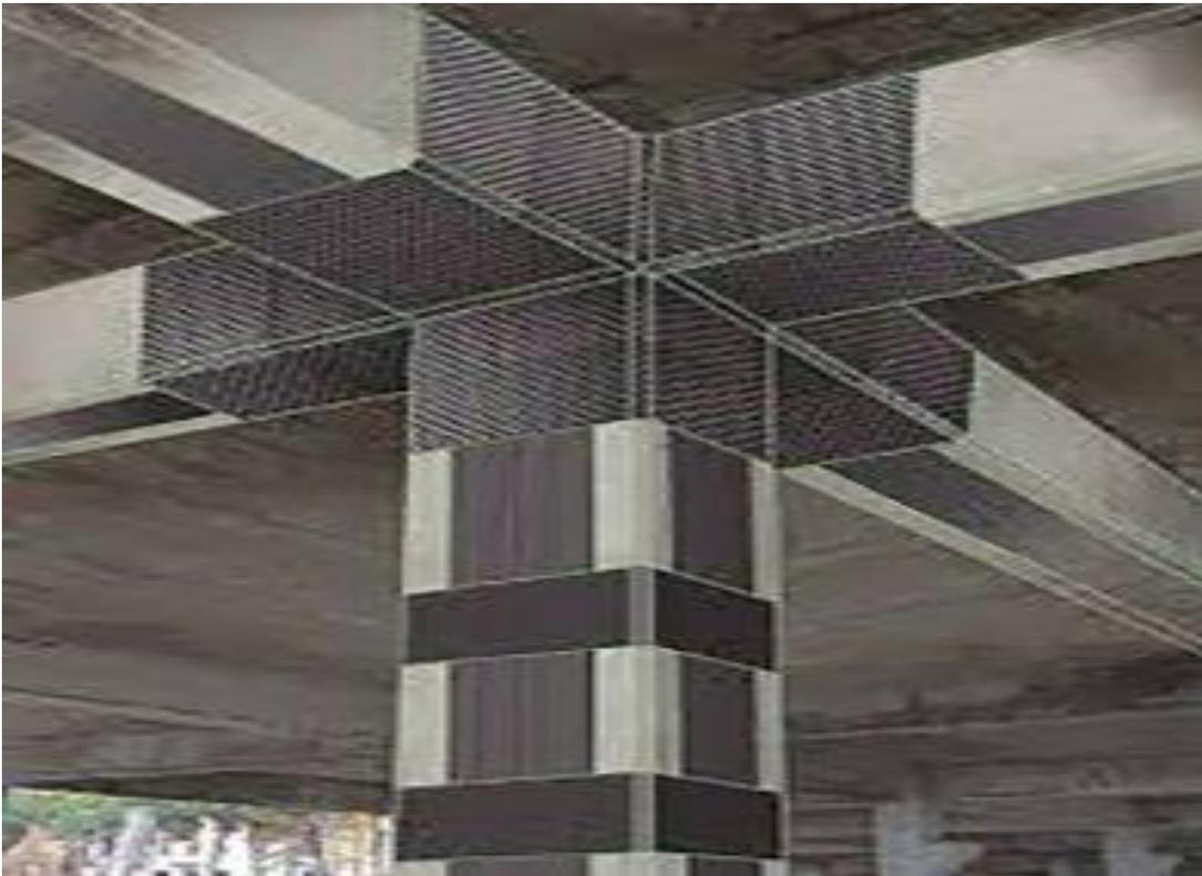
Figura 4c. Consolidamento del telaio in c.a. mediante fasce di carbonio con specifica disposizione per il rinforzo a taglio e a flessione
