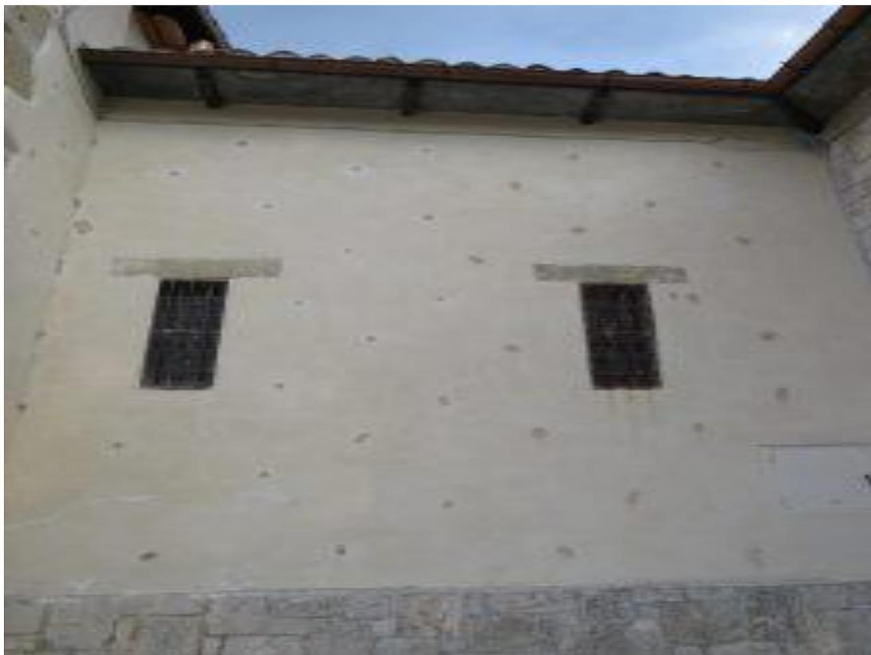
Figura 1b. Consolidamento delle pareti eseguito con iniezioni di malta di calce
