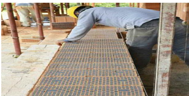
Figura 6 – Posa in opera dei mattoni in laterizio isolati.
