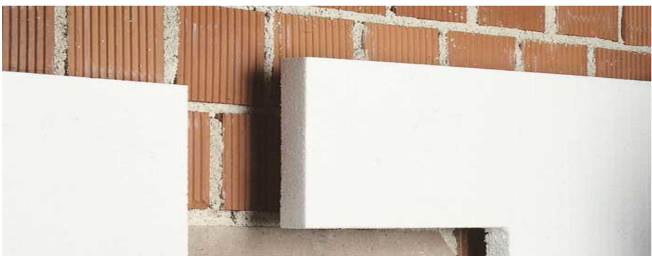
Figura 3 – Il posizionamento del cappotto
