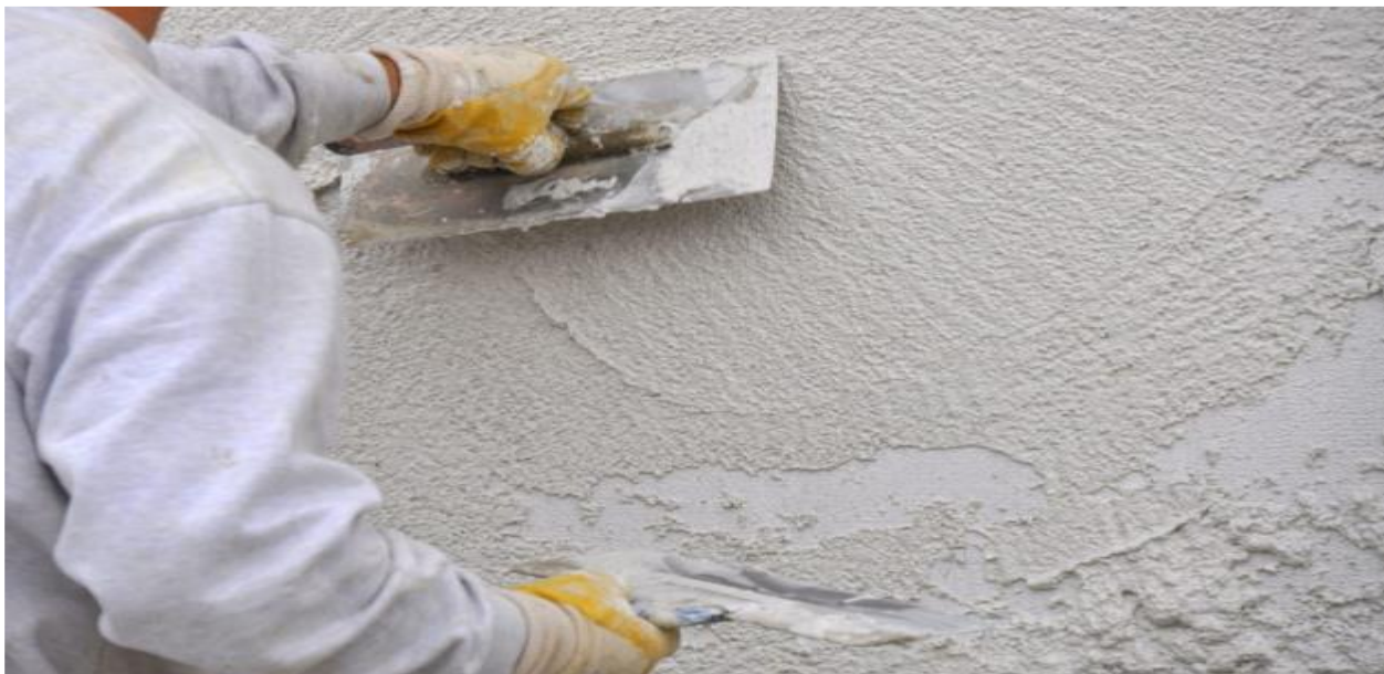
Figura 5 – Applicazione a mano del rasante termico su superficie esterna
