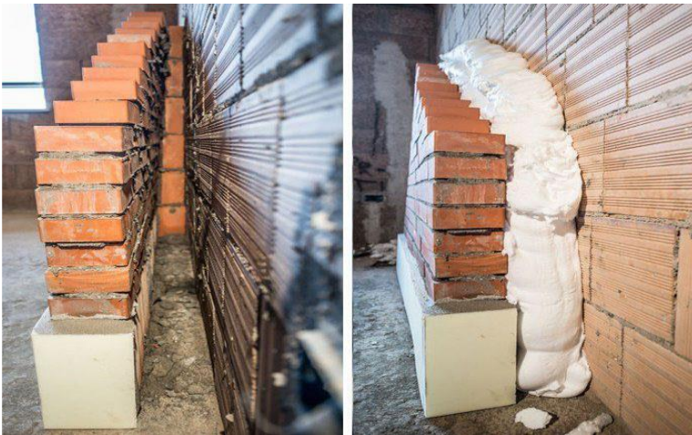
Figura 1 – Isolamento termico in intercapedine in schiuma poliuretanaica.
